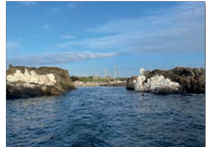
Besondere Hafeneinfahrt. Ein ehemaliger Steinbruch dient hier als Hafenbecken. Die Einfahrt wurde in den Felsen gesprengt. Eine „Sill“ – in diesem Fall keine Mauer, sondern die Felsenunterkante – hält den Wasserstand bei Niedrigwasser im Hafenbecken. Das „Ein- und Ausfahrtszeitfenster“ wird per Gezeitenkurve für den Tag vorausberechnet.
