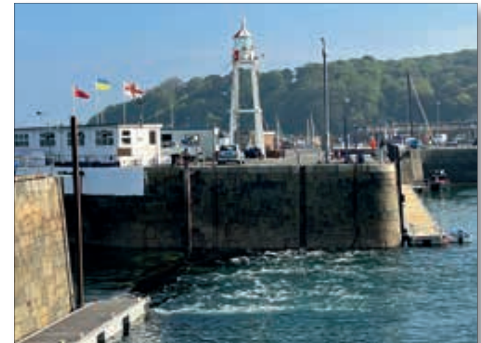
Die Sill bei auflaufendem Wasserstand
