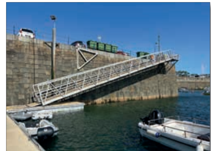
Tidenhub anschaulich: Kaum zu glauben, aber die Rampe ist bei Hochwasser fast waagrecht
